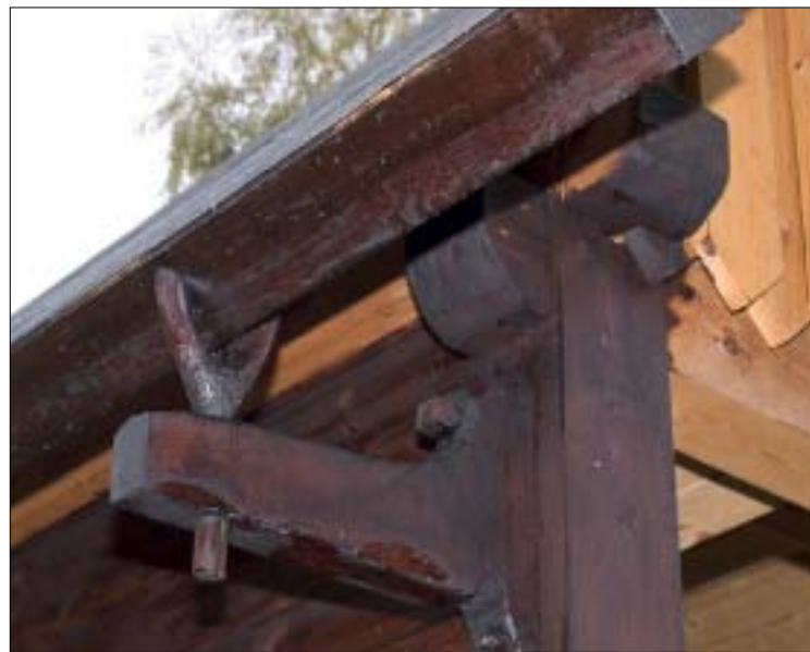
Hängränorna hålls fast med grenklykor.
