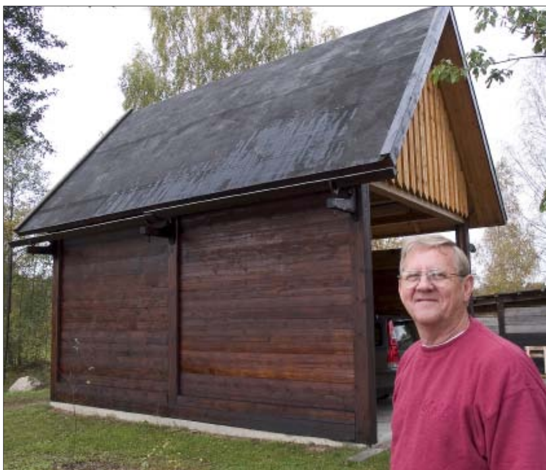
Börje Gustavsson framför sitt första bygge i skiftesverksteknik. Det tjänstgör just nu som garage, men ska bli bostadshus. Lagg märke till hängränorna, som är av trä, vilket enligt Börje fungerar utmärkt.
