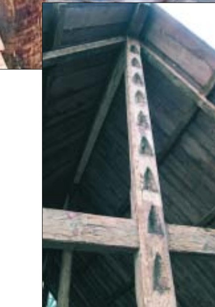
Fast steg huggen ända upp till stallets nock.
