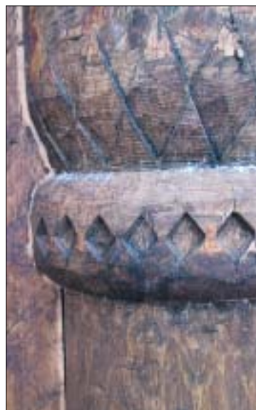
Nyttillverkad stolpe men patinerad för att verka gammal.
