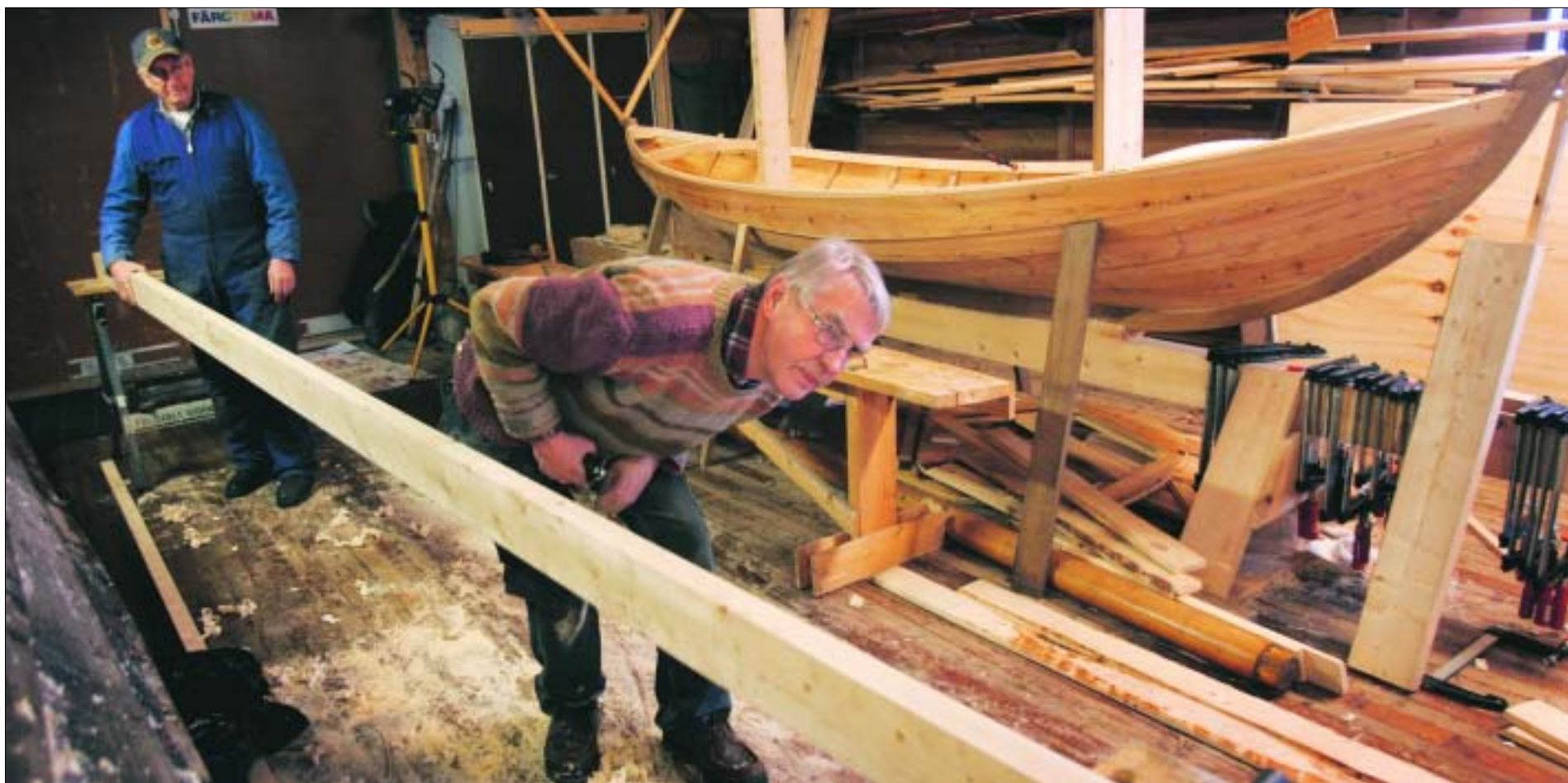
För att byta bottenstock krävs bra virke och duktiga hantverkare. Det första ordnar solosågen, för det andra står bl a Sven-Ove Eriksson och Göran Viklund.
