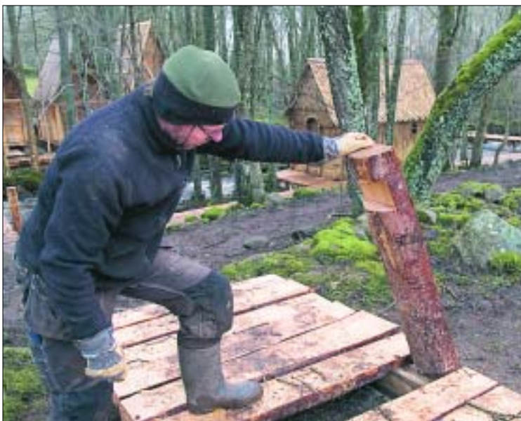
Trätrottoarerna byggdes snabbt och enkelt med solosågen. Kapa stockar och klyv på mitten. Hugg ut spår på undersidan så att de hålls fast i plankor som ligger på marken.
