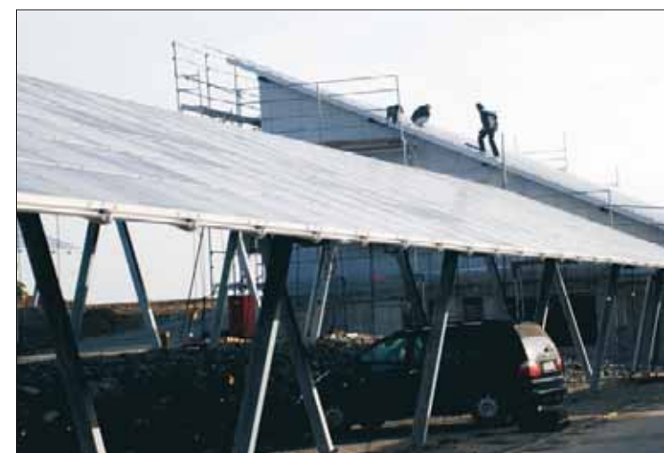
Södra Tyskland är inte bara rikt på skog. Det är en region som hårdtsatsar på alternativ energi. Bland annat utnyttjas taken maximalt för solpaneler, här ett energiproducerande tak över en bilparkering i närheten av Logosols tyska kontor
