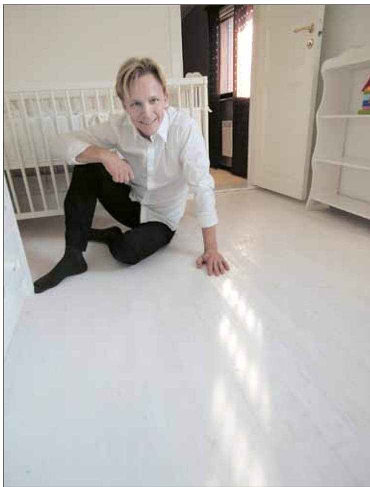
Golvet som Mattias Byström lagt in är ett reparationsgolv. Granbrädorna är 13 mm tunna, i längder från 0,5 till 1 meter.
