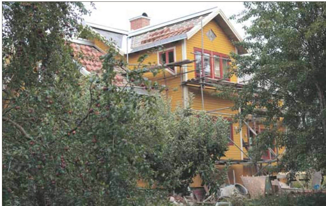
Istället för att riva och bygga nytt, har det gamla huset bevarats och fått ytterligare en våning.
