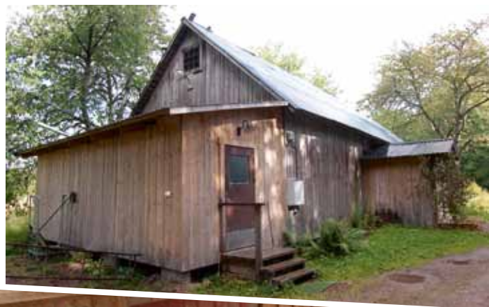
Ökna-Ladan är renoverad och utbyggd i båda ändar med egensågat virke.
