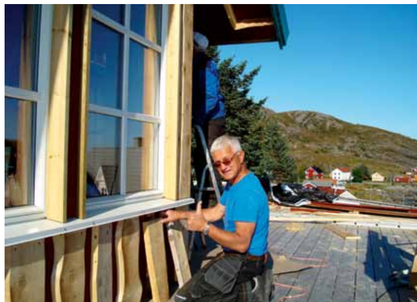
• Kristian skrur fast villmarkspanel av 11/4 sitka. Legg merke til det røffe panelet.
