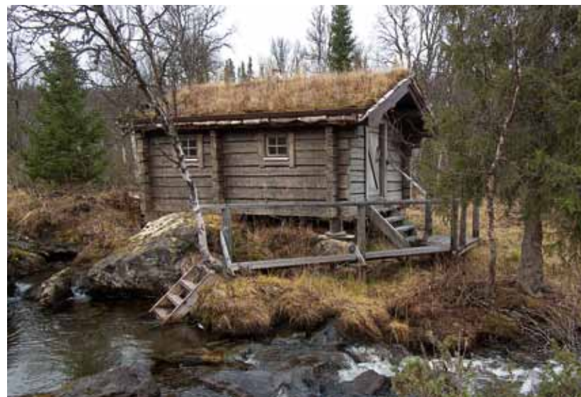
• Den vedeldade bastun ligger mitt i en brusande fjällfors.
