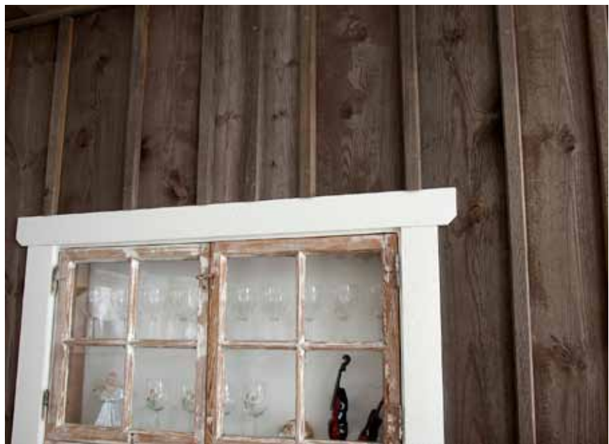
• Panelen behandlades med järnvitriol och fick ligga utomhus ett år, för att få den rätta grå nyansen.
