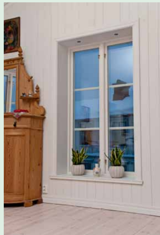
• Höga allmogefönster med djupa smygar och infällda spotlights är husets stolthet. Listerna är hyvlade på Solohyveln.
