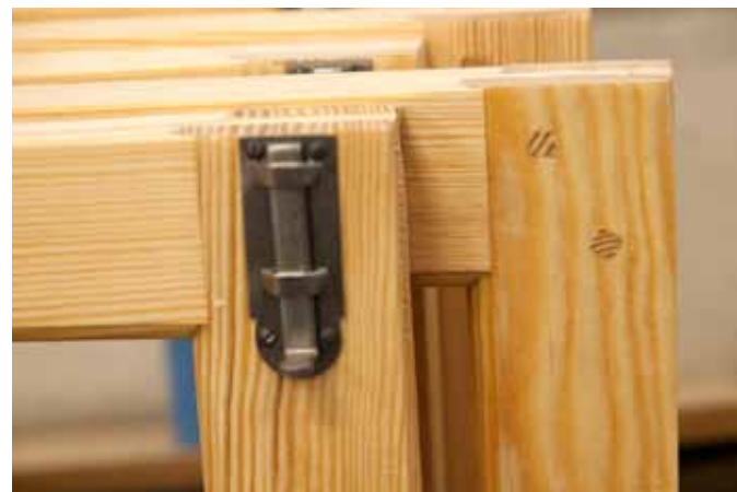
Fönsterbågarna sammanfogas med träplugg för att det i framtiden ska vara lättare att byta skadade detaljer.
