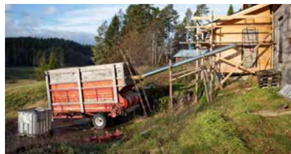
• Spånfläkten står i en nybyggt litet hus. Spånet sprutas direkt till vagnen som tidigare fungerat som dyngspridare.
