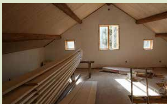
• Stockarna i taket ger huset karaktär.
