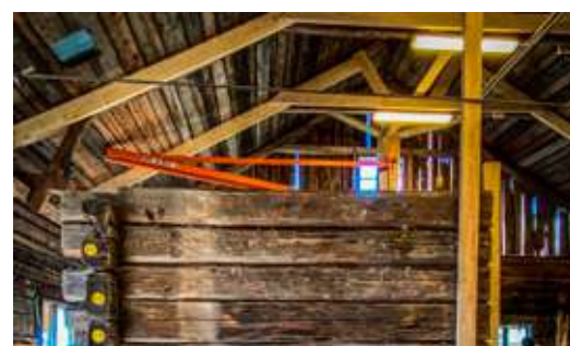
• Reparation av äldre timmerhus i f.d. verkstaden
