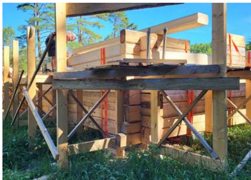
• Timmrandet underlättas väsentligt när alla stockar är frästa och passar perfekt direkt.
