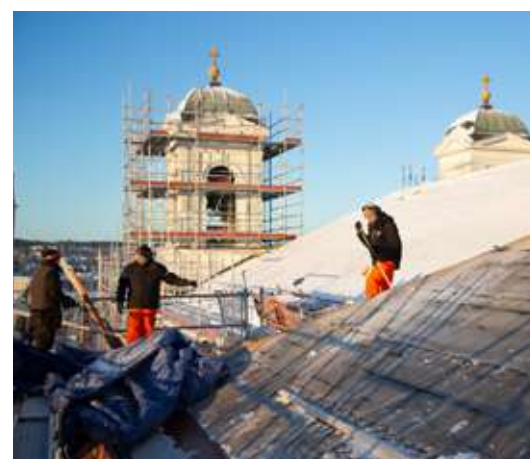
• Första tornet är renoverat, nu dags för de andra två.
