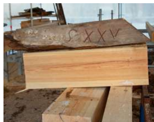
• En mer än hundra år gammal bit balk som märkts av dåtidens snickare. Biten ersätts nu av en komponent av kärnfura som kommer att hålla i många hundra år.
